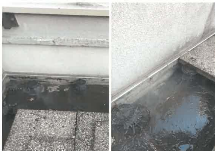
Réalisation d'un test fumigène. Apparition de la fumée blanche au droit des relevés.
