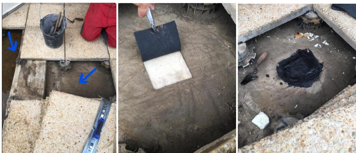
De l'autre côté du joint de dilatation : R.A.S pas d'eau stagnante et isolant sec.
