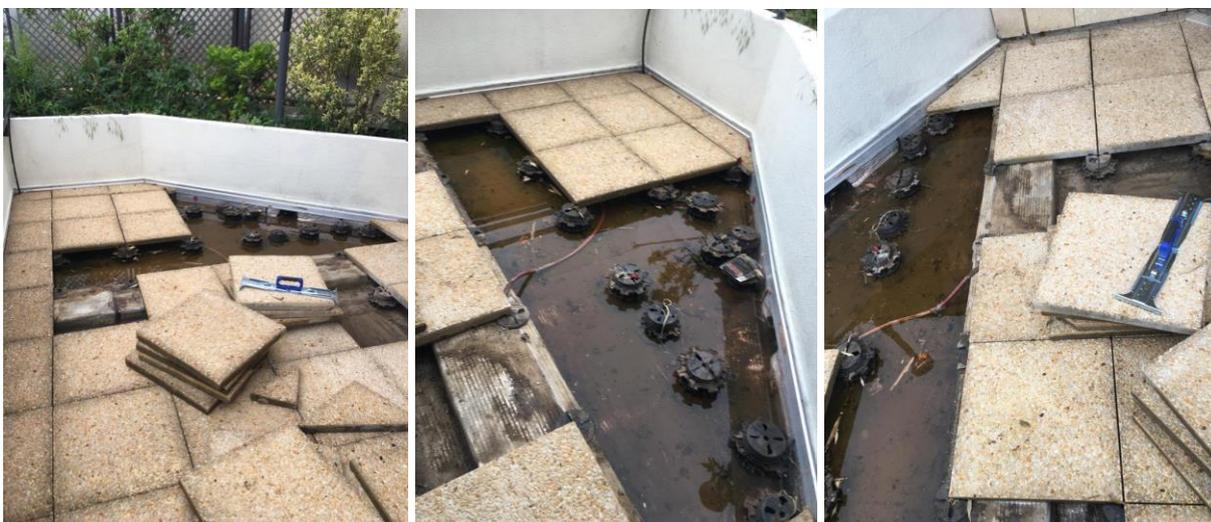
Dépose des dalles sur plots et constat d'une stagnation d'eau entre la jardinière et le joint de dilatation dessous les dalles.
