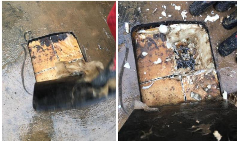
Réalisation d'un sondage : Présence d'eau dessus l'étanchéité, isolant imbibé d'eau.
